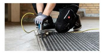
Wo Tausende von Begehungen erfolgt sind, sind manchmal Erneuerungen nötig. Durch einen Wechsel der textilen Einlagen lässt sich die Lebensdauer der Eingangsmatten leicht verlängern. Das Aluminium-Trägerprofil bleibt gleich, nur die Einlagen werden ausgetauscht. Mit einer speziell entwickelten Vorrichtung kann dieser Wechsel vor Ort durchgeführt werden – so ist die Eingangsmatte direkt wieder einsatzbereit.
